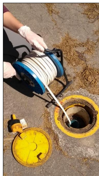
Figura 23. Medição de nível estático e profundidade do poço de monitoramento anteriormente à execução dos ensaios.
